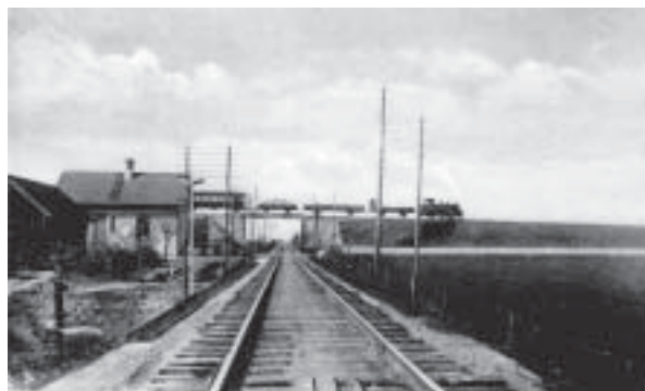
Viadukten där järnvägen mellan Lund och Bjärred passerade Lommabanan
