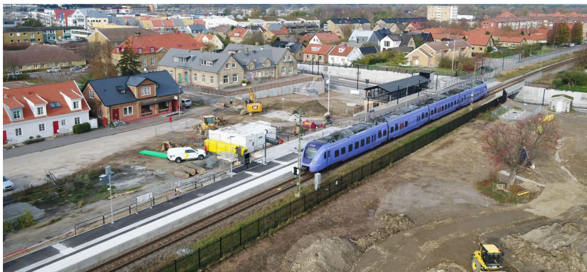
Arbete med att bygga Lomma station.
