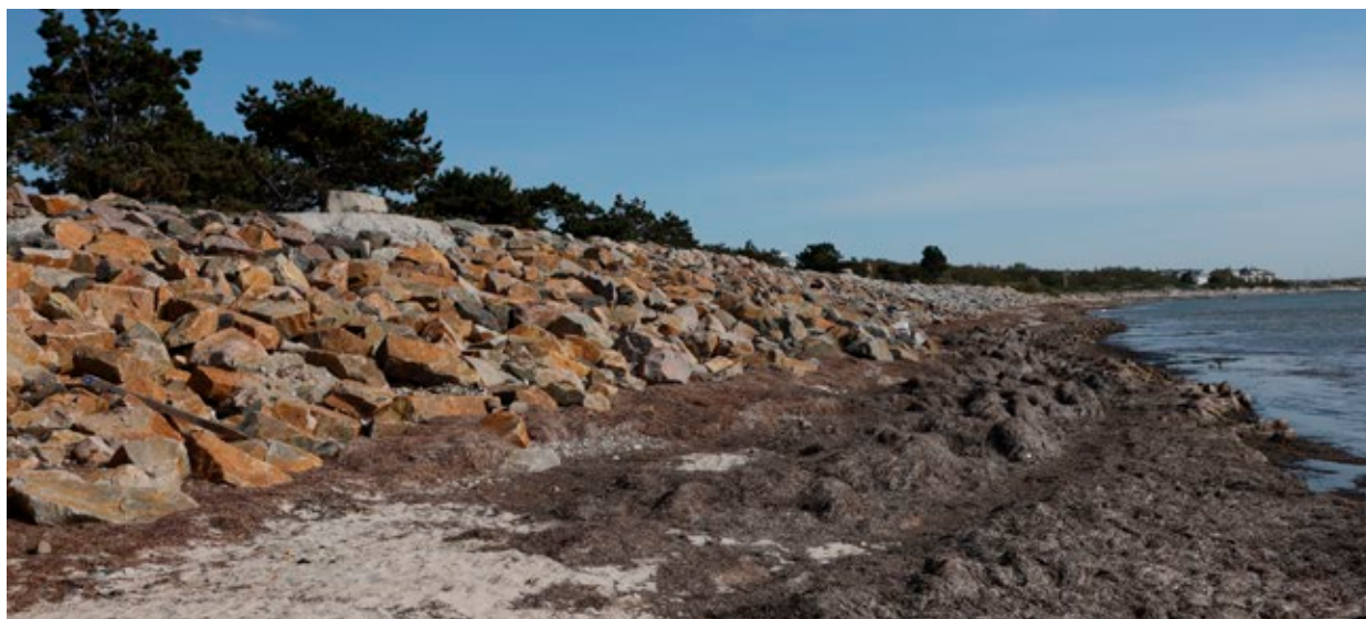
Erosionsskyddet vid Fyrkantsdammen.
