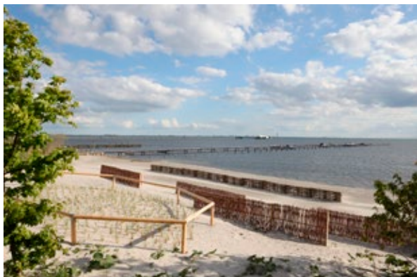
Erosionsskydd längs kuststräckan i Bjärred
